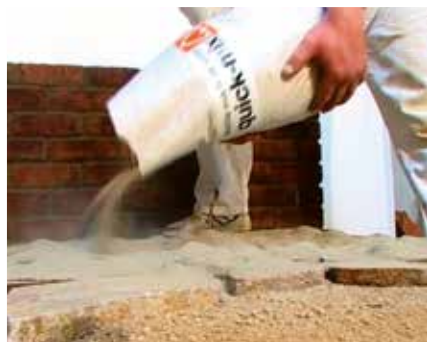
3 Materiál v suchém stavu volně nasypeme na suchou položenou dlažbu.
