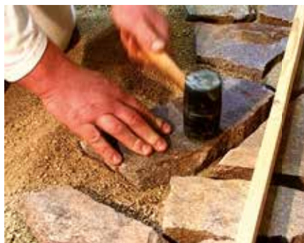
1 Dlažbu pokládáme do malty NVL 300. Lepíme materiálem RKS a F-DBK.
